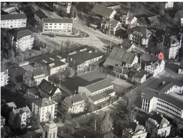
Das Wirtshaus Vorderberg war noch an Nachbarhäuser angebaut Fluntern_QV-Vortrag_21
