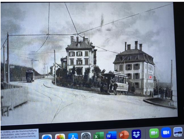
Das Tram mündet von der Voltastrasse in die Gloriestrasse ein ...
