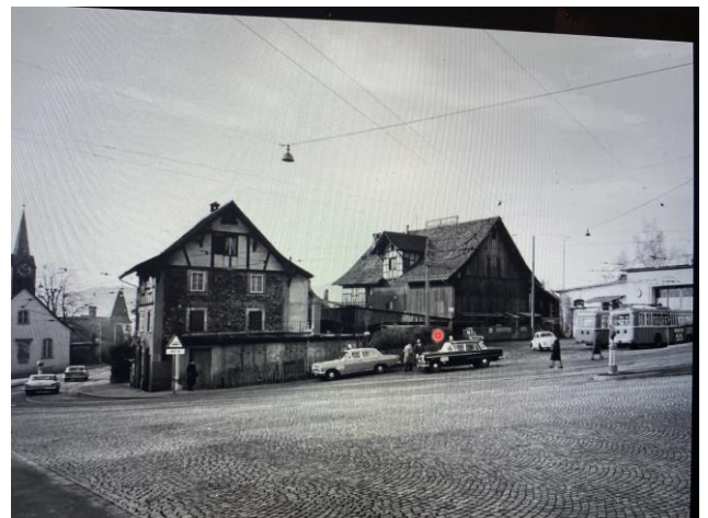
Tramdepot beim Vorderberg, dann Feuerwehr, nun Seniorenheim
